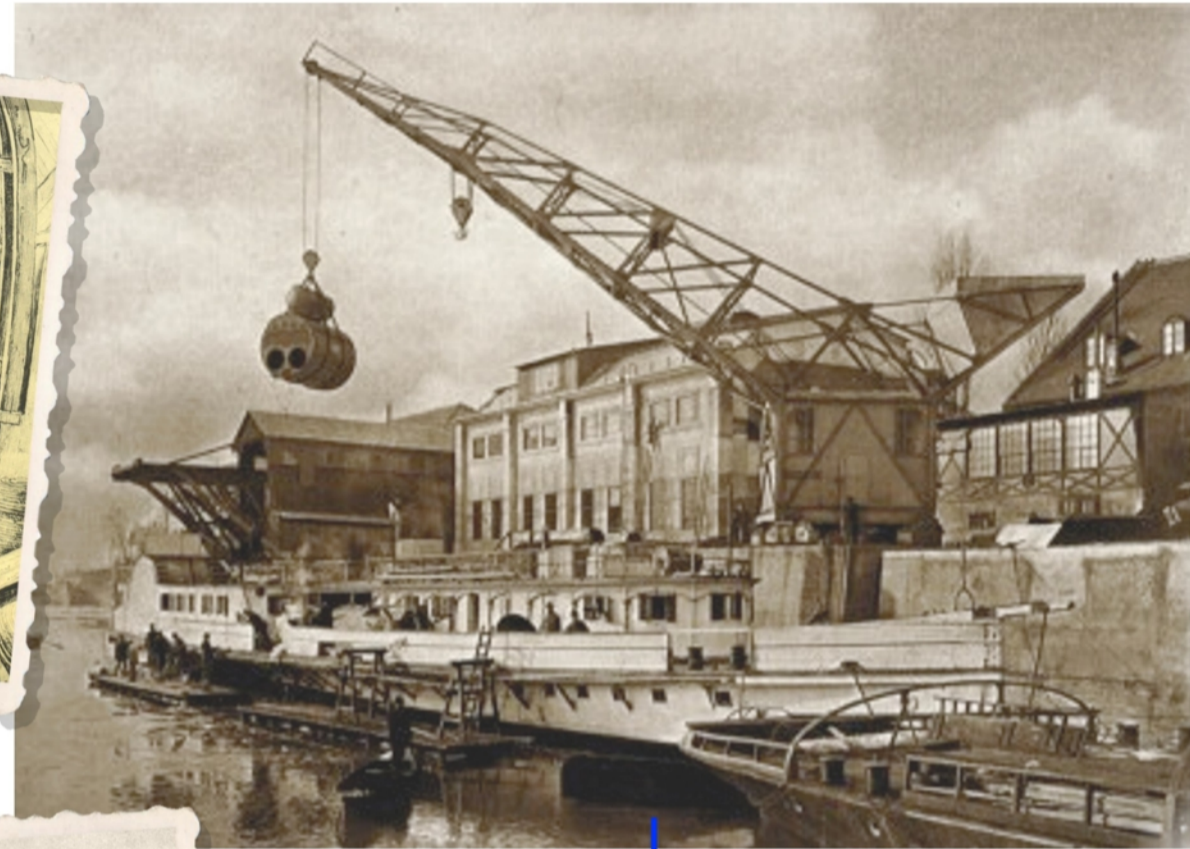
Az 1902-ben felszerelt új kazáncsaru (a háttérben még ott a régi) The new boiler crane from 1902 (old crane is on the left in the background)
