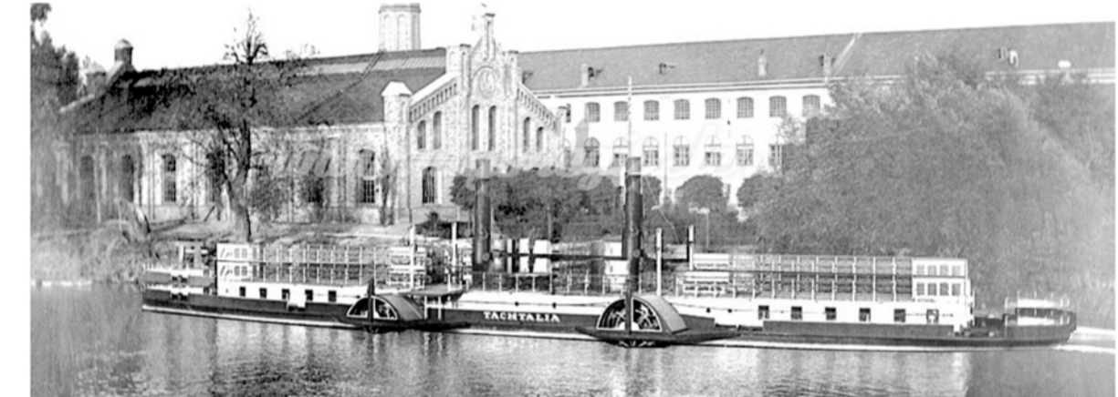
Az al-dunai zuhatagokra készült 4 kerekes TACHTALIA személyhajó (1854) The four wheel paddle steamer TACHTALIA passenger ship built for the cataracts of the Danube (1854)
