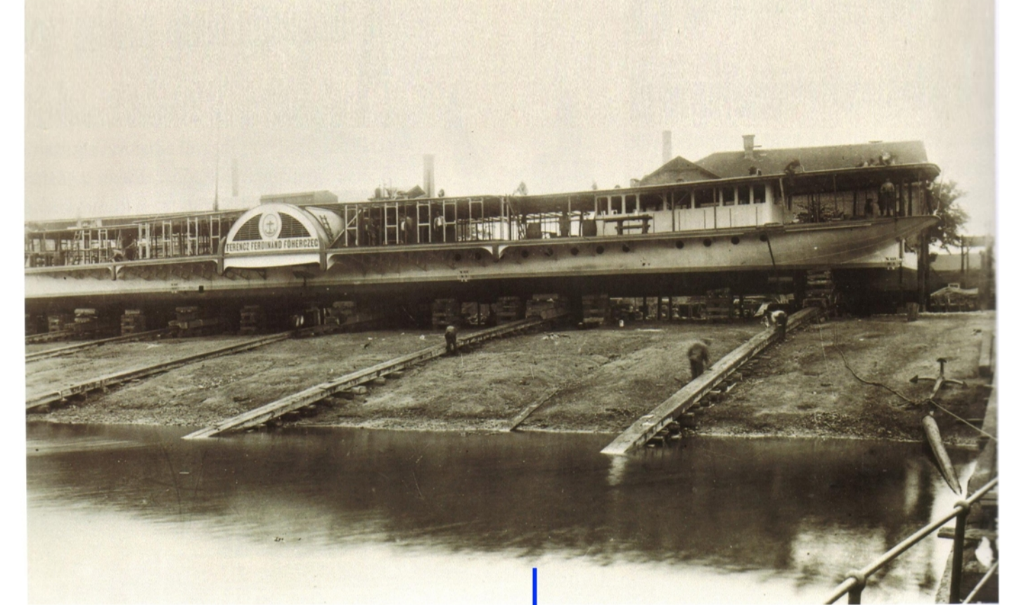
A "sufni" lebontása után kialakított új sólyatéről már oldalt bocsátották vízre a hajókat New method of the launching on the new open-air slipway built after the demolition of the old roofed slipway, calling "the hut".
