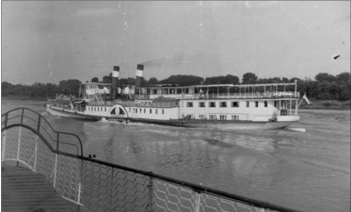
Termesgőzösök passzálása. Jól látható a kémények két oldalán a még beépítetlen fedélzet.
