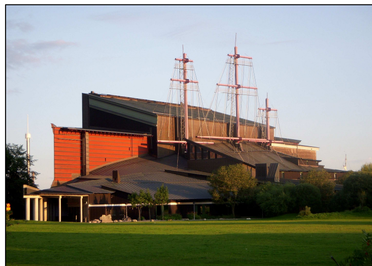
A kiállítócsarnok tetejéből kinyúló „árbocok” imitálják az eredetit.
